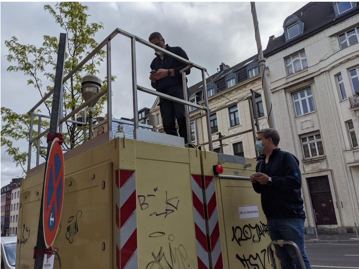
Abbildung 32: Installation der AirQuality-Sensorbox auf dem VACW-Messstationscontainer in der Wilhelmstraße in Aachen
