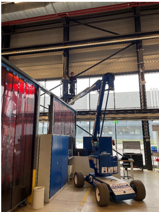
Abbildung 30: Installationsprozess der zusätzlichen Anker (UWB-Empfangsantenne) und mobile Drohnen-Start-und-Landezone in der DFA
